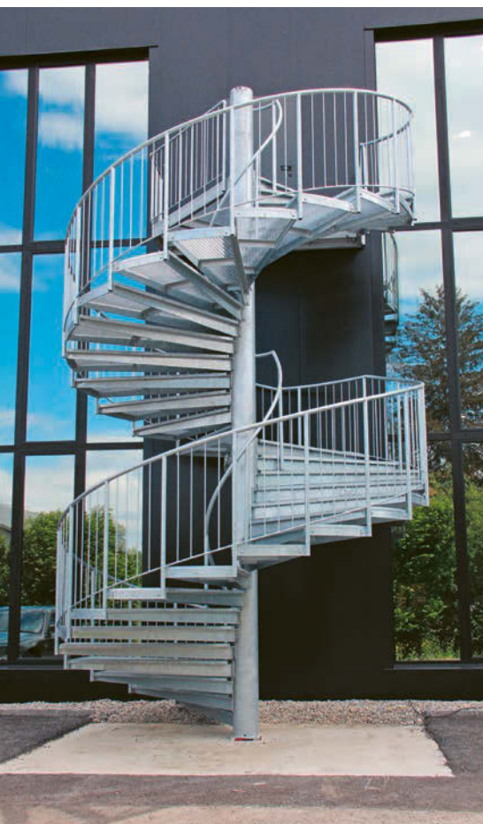
Zwei Gitterrost-Spindeltreppen gewähren den Fluchtweg am Firmengebäude.
