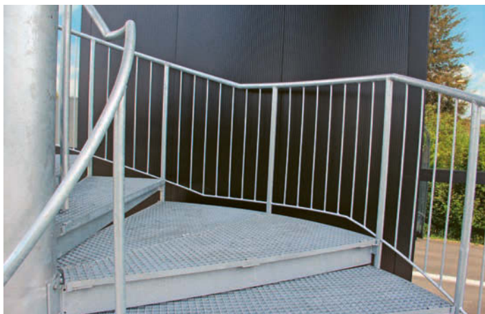
In der Mitte ist ein Podest eingebaut. Es ermöglicht ein Ausruhen während der Begehung.
