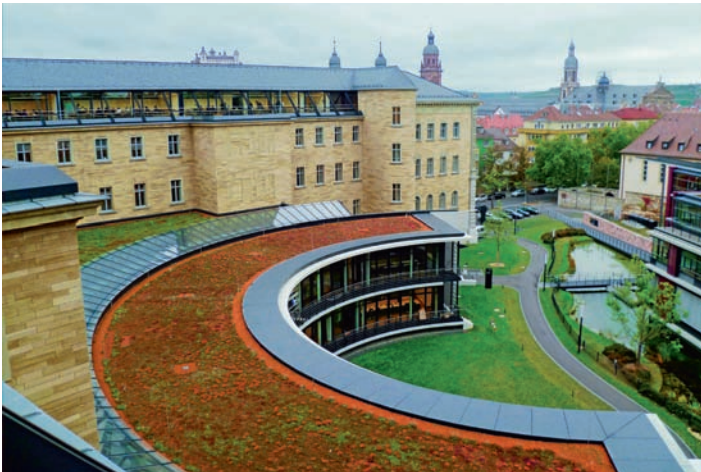
An das im Halbrund gezogene Oberlichtband wurden erhöhte Anforderungen an die Weiterleitung des Längsschalls gestellt. Die Rundung wird durch polygonal aneinandergereihte Gläser erreicht.
