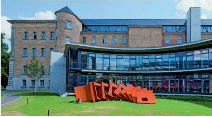
Zum Strafjustizzentrum hin schliesst eine Pfosten-Riegel-Konstruktion aus Stahl und Glas den halbrunden Erweiterungsbau ab.
